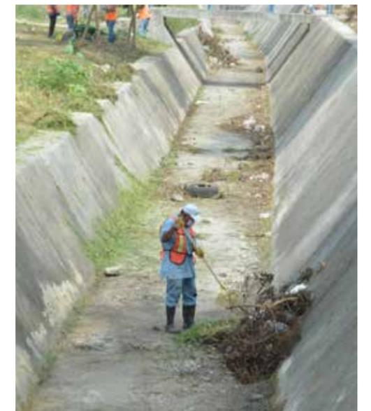
En esta tarea se destinan, de manera permanente cuadrillas de trabajadores y equipo motor para realizar labores de limpieza, desazolve, y retiro de basura especial acumulada. En el último año, se han retirado de esta red de canales, alrededor de 59 toneladas de basura y material contaminante.
